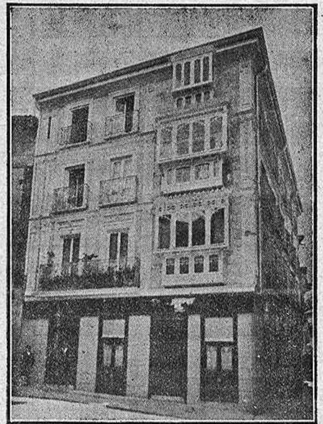
Barrio Rey, 2, 4 y 6, Teléfono 14, TOLEDO
