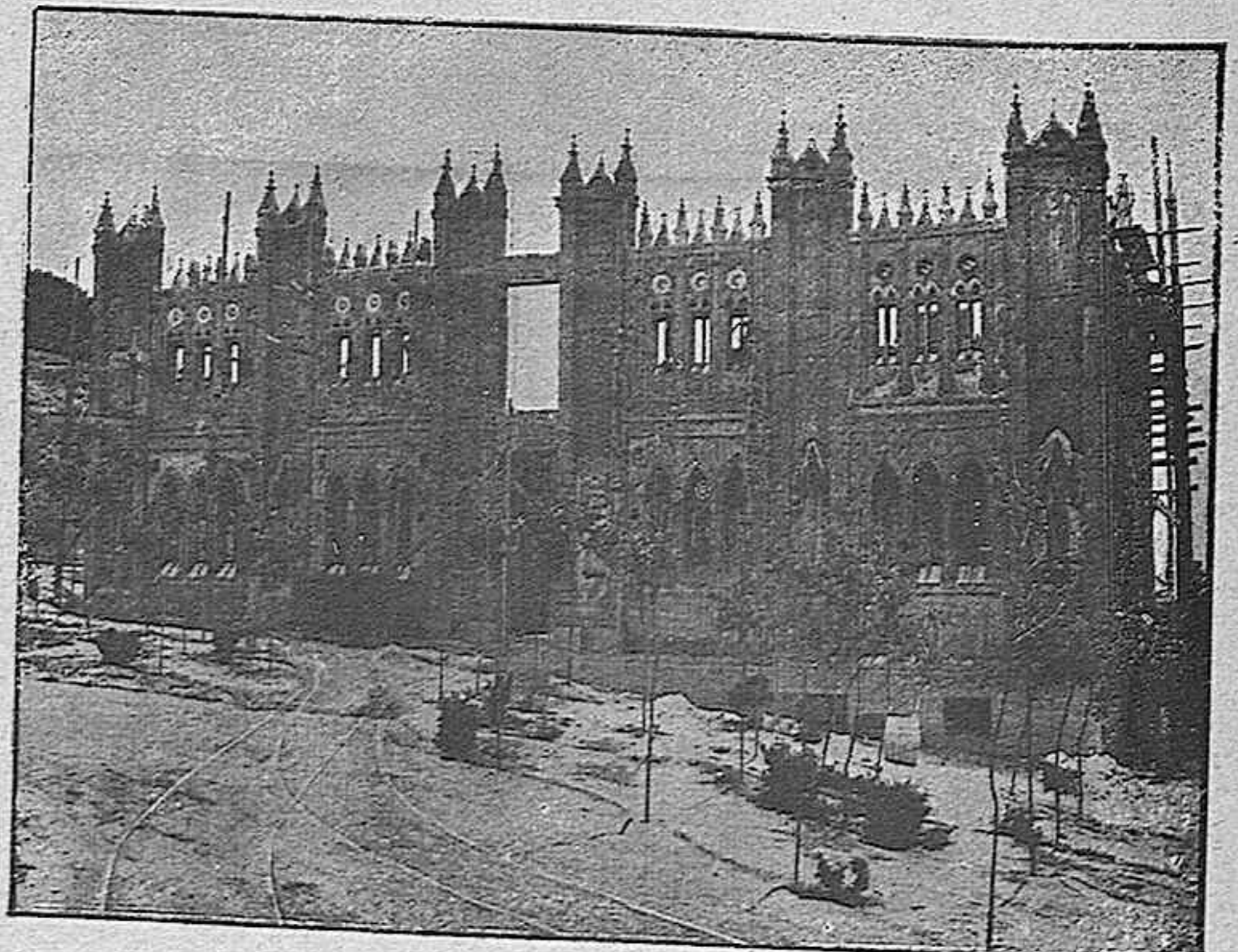
Iglesia en construcción.
