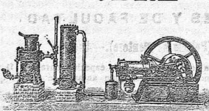
Gasógeno DEUTZ para gas pobre sin caldera y sin gasómetro
