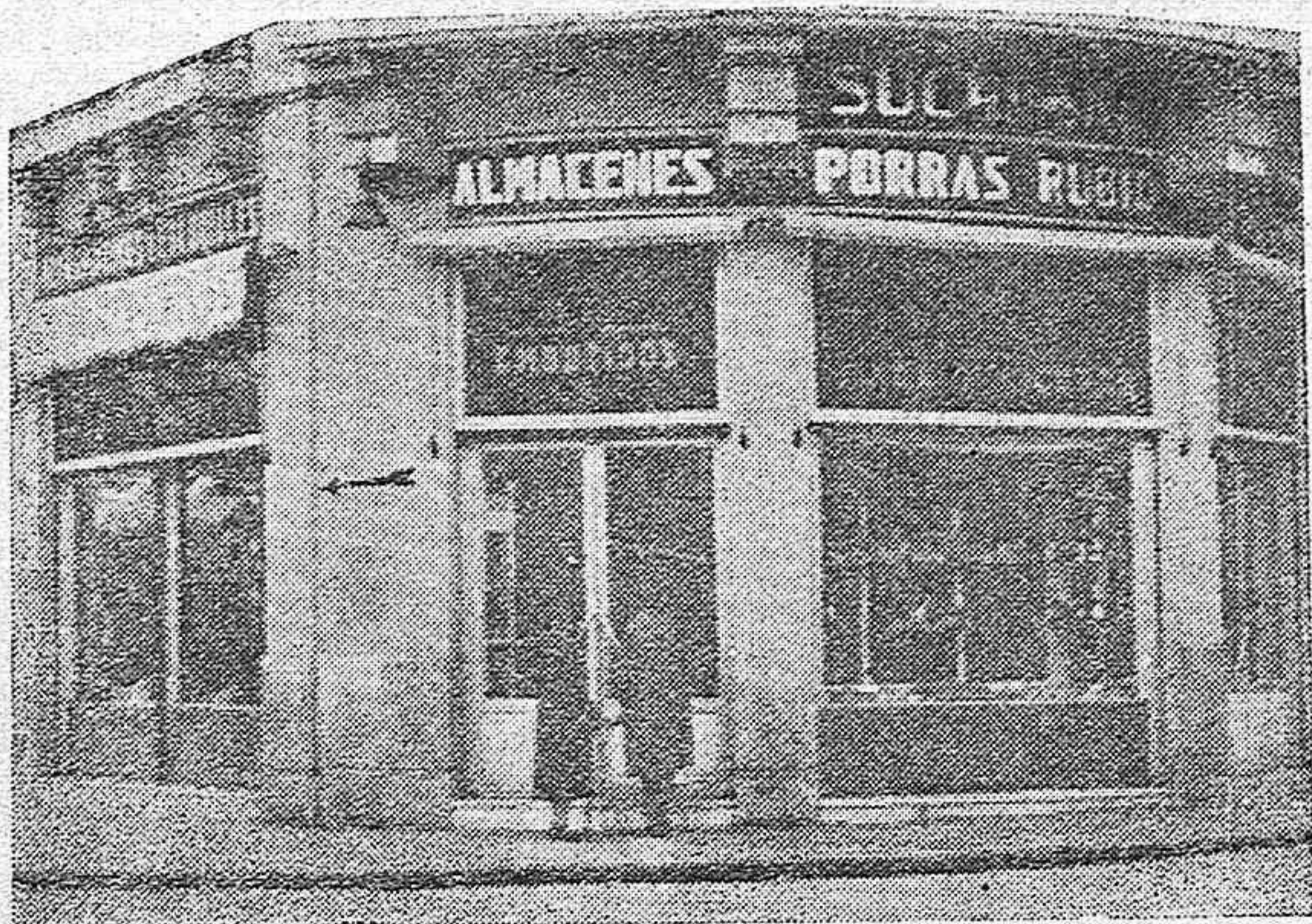
VISTA PARCIAL DE LA SUCURSAL DE LA CALLE MALAGA
