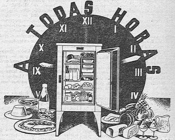
tendrá sus alimentos frescos y podrá disponer de bloqueitos de hielo limpio e higiénico. Unico armario frigorífico que funciona por electricidad, gas o petróleo, careciendo de motor compresor y partes móviles.
