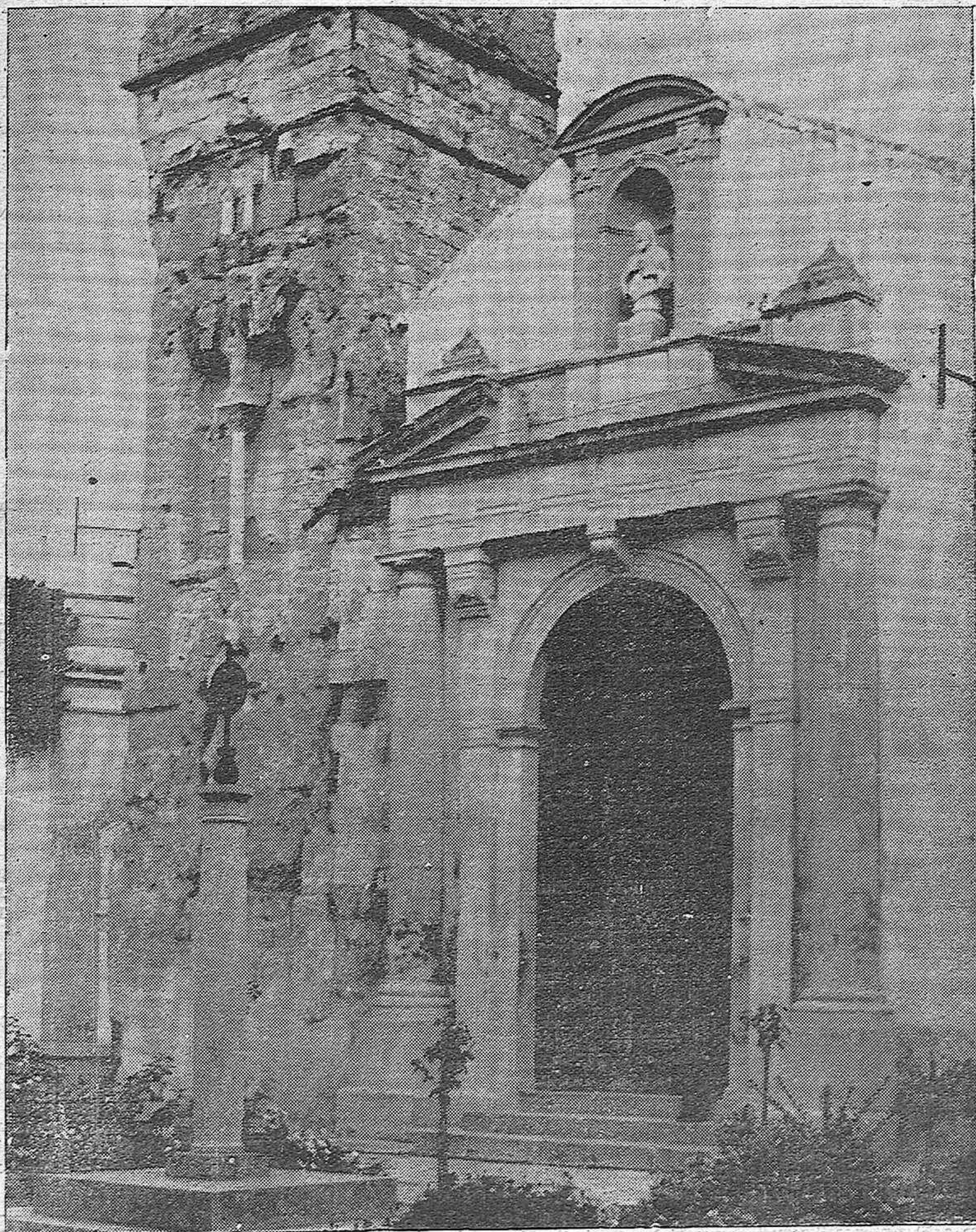
CORDOBA MONUMENTAL.—Torreón árabe que se alza adosado al Convento de las Repañadoras, en la Plaza de San Juan. (Foto Torres)
