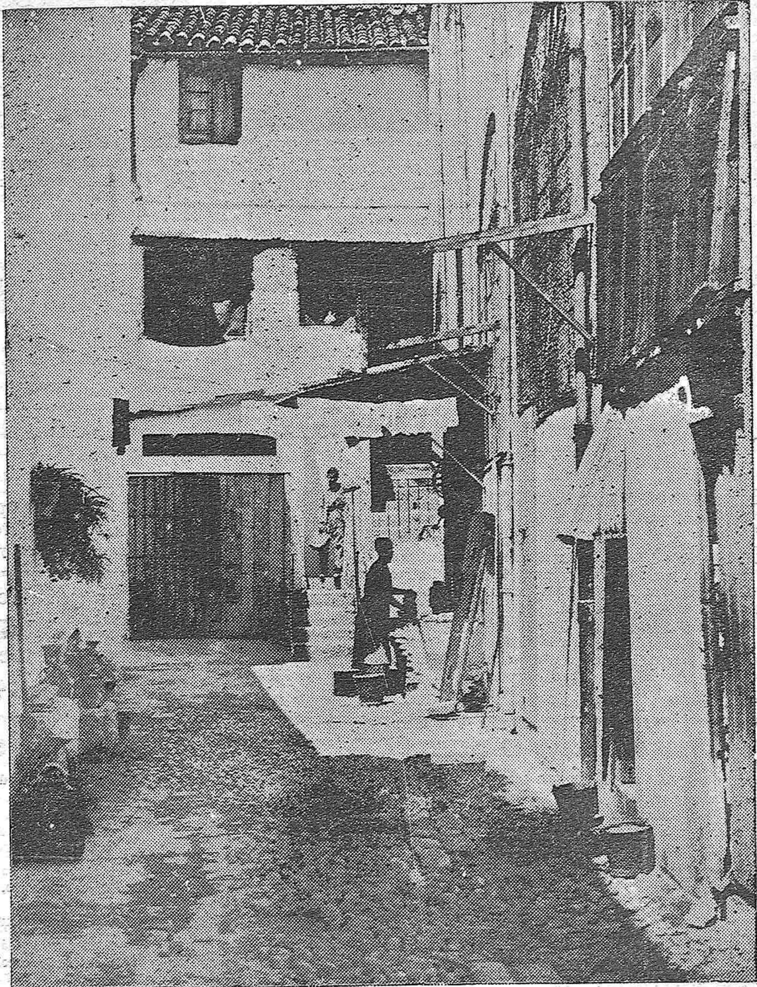
EL PROBLEMA DE LA VIVIENDA.—Callejón de entrada a la casa de vecinos llamada del Baratillo, en la Corredera baja. La alegría que parece emanar del típico patinillo oculta el vivir negro y d amática de muchas criaturas de lo que nos ocupamos en nuestro reportaje de esta tarde.
