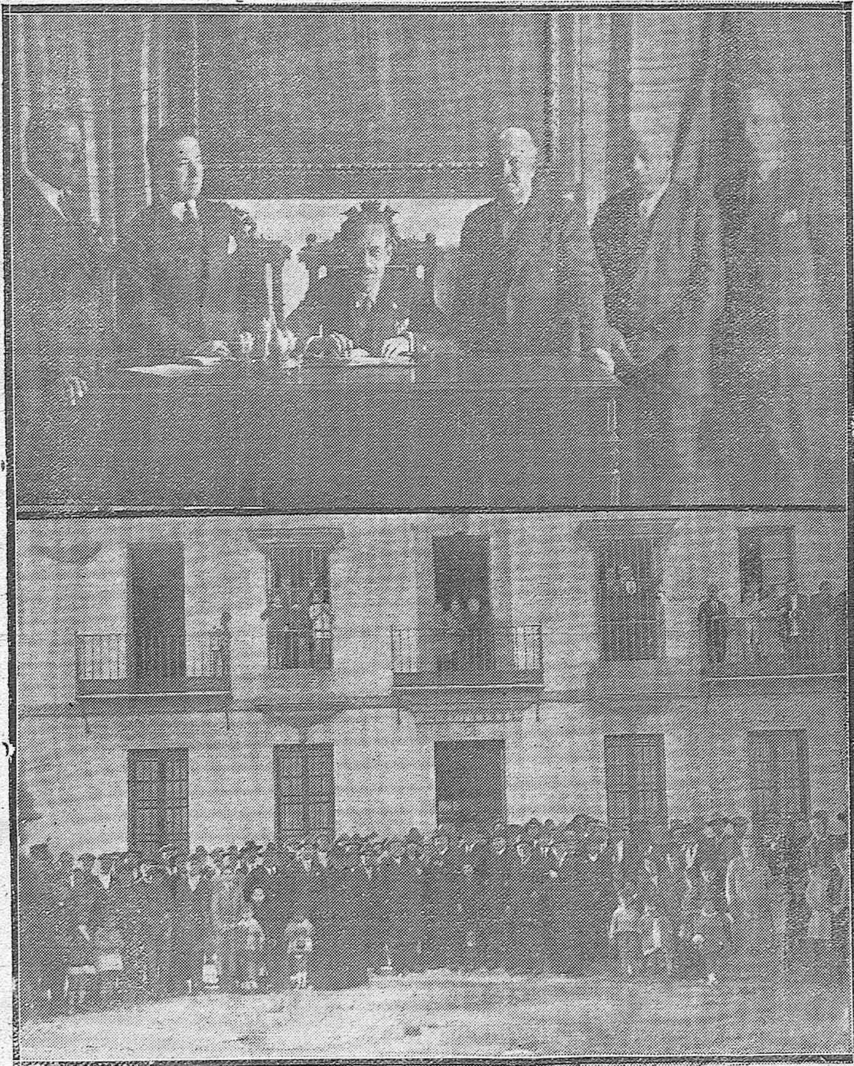
PRIEGO DE CÓRDOBA: El alcalde don José T. Valverde, firmando la escritura de adjudicación al Banco de Crédito Local de las obras de abastecimiento y red de distribución de aguas potables, alcantarillado y pavimentación.—CÓRDOBA: Concurrentes al acto de la entrega de una casa por el Banco de Ahorro y Construcción a uno de sus asociados.
