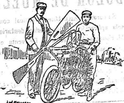
El aparato que fué probado es un motociclo provisto de un motor Buchet con dos cilindros en V de corazón y fuerza de 6 H. P., el cual acciona por medio de dos poleas, un arbol á cuya extremidad hay fija una hélice, cuyas paletas son de aluminio de un diámetro de un metro cincuenta. Esta hélice está colocada en la parte delantera de la bicicleta.
