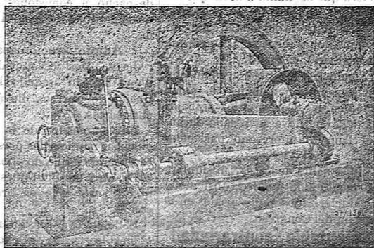
Motors de marcha rápida para acoplamiento con dinamos y bombas de gran velocidad (necesitan poco espacio y no tienen pérdida de energía en la transmisión de la fuerza).
