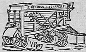
MÁQUINA Á VAPOR y bomba para riego.
