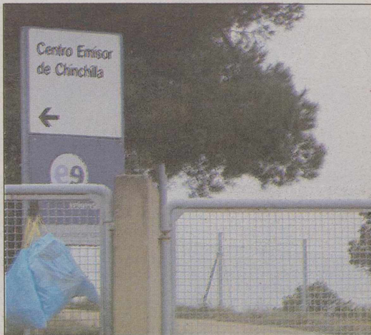
El centro emisor está instalado en un monte de Chinchilla. J.M.
