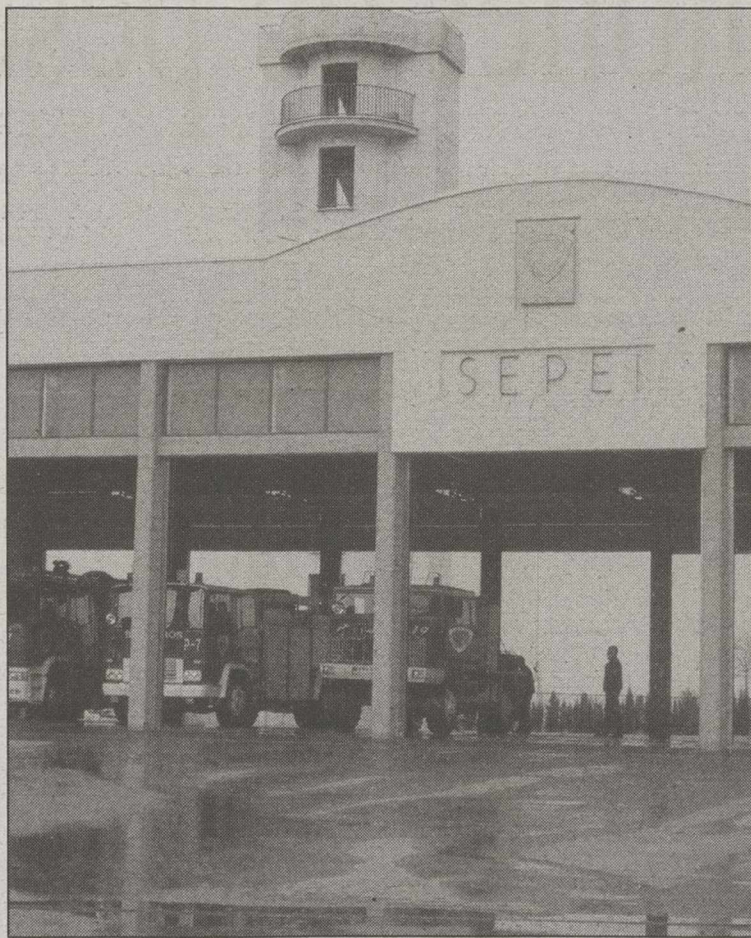
Instalaciones del parque comarcal de bomberos.
