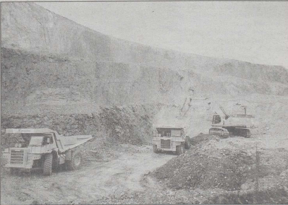
Las obras se realizan en las proximidades del Polígono Industrial.
