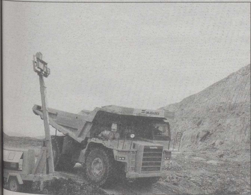
Las obras cuentan con la intervención de maquinaria pesada.
