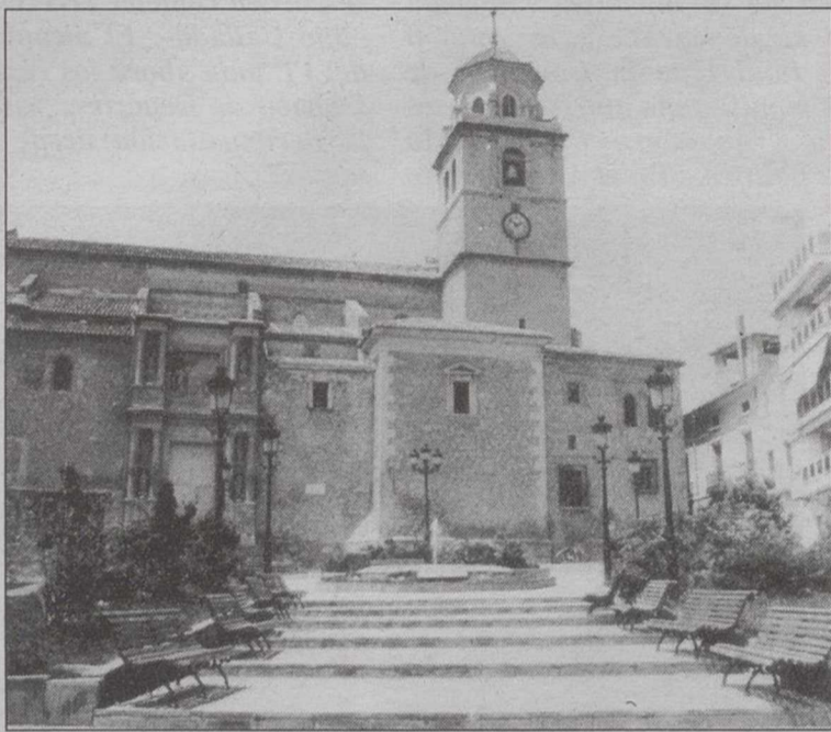
Un millón de pesetas para las obras de remodelación.
