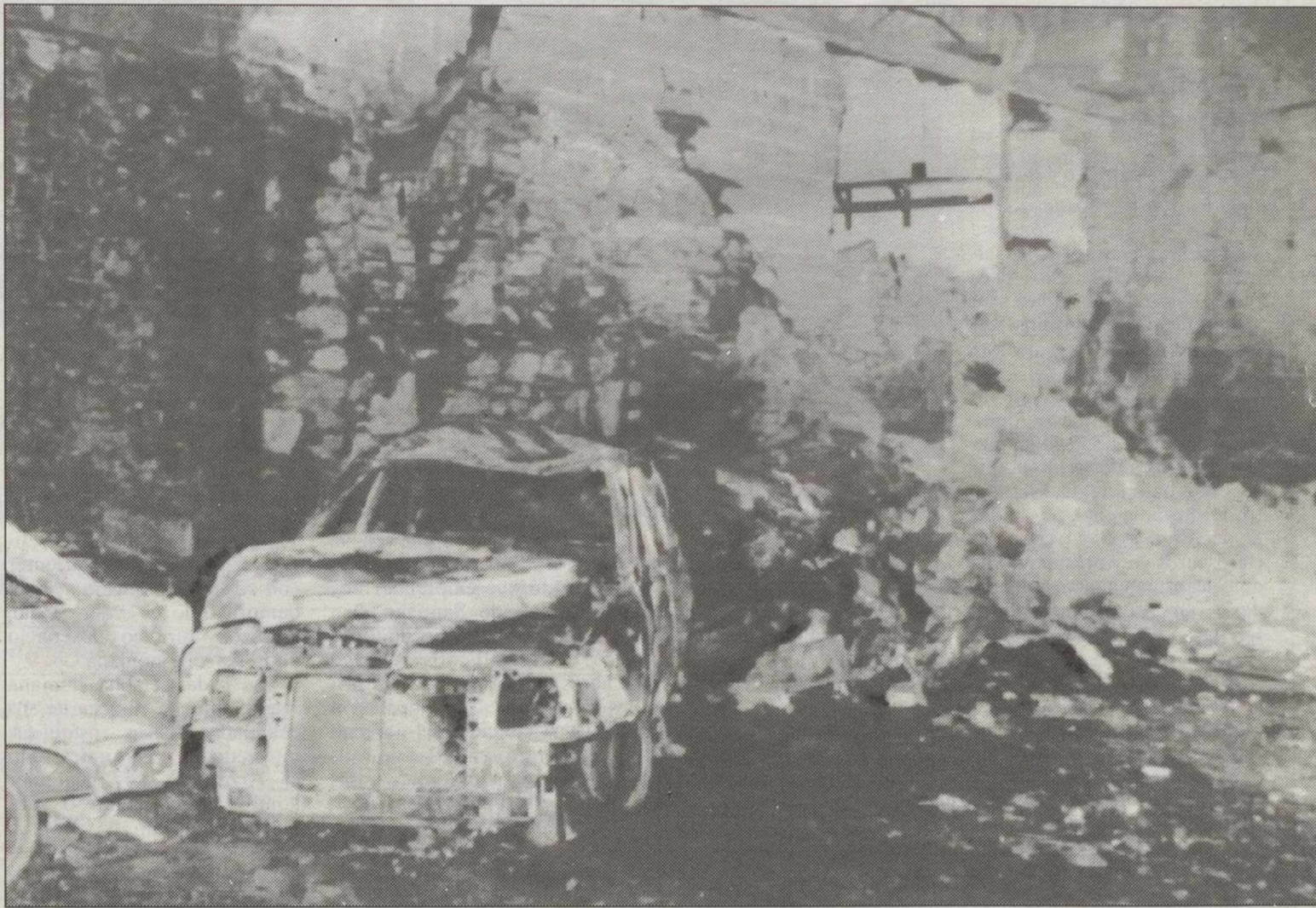
Aspecto que ofrecía la fachada de la casa cuartel de Irún tras la explosión de un coche-bomba.
