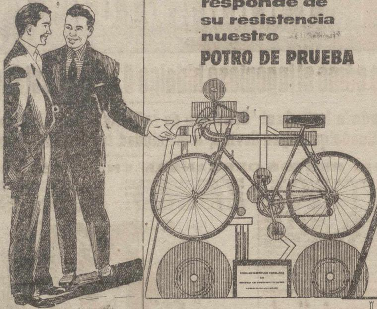
Ud. compra una bicicleta que antes de salir de la fábrica, ha sido verificada por piezas y, una vez montada, sometida a prueba de ajuste y resistencia en nuestro famoso "Potro de Prueba".
