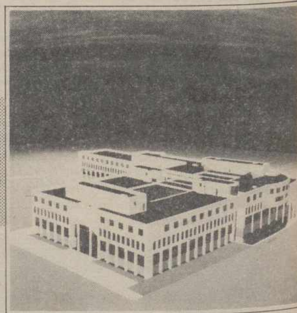
DELEGACION DE VALLADOLID En construcción
