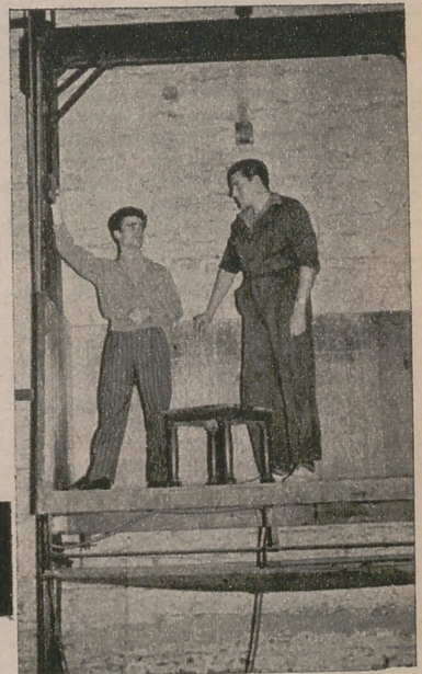
Ascensor en el escenario de un teatro, muy útil para los servicios de tramoya
