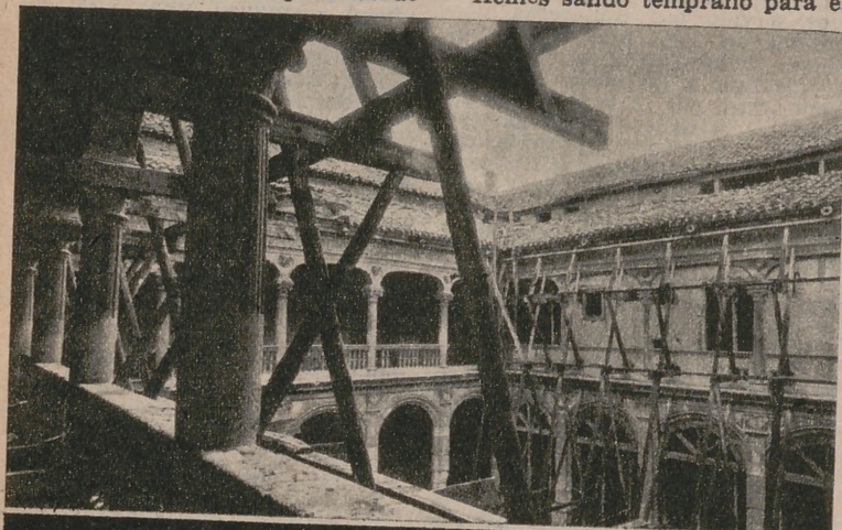
El palacio de Avellaneda, en Peñaranda, en reparación
