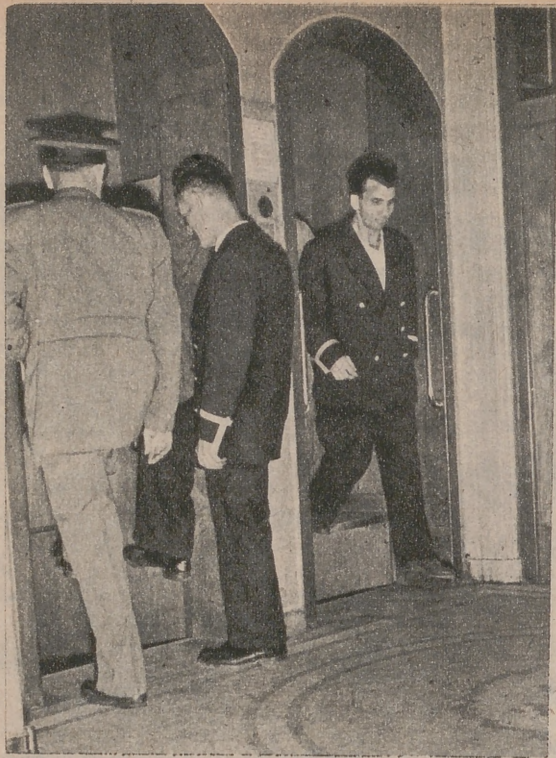
Moderno ascensor individual, de movimiento continuo, instalado en el edificio del Parque Móvil de los Ministerios, de Madrid
