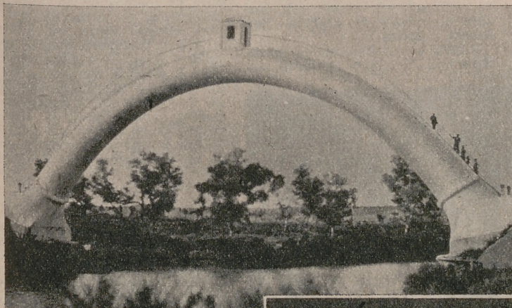
Arriba: Panorámica aérea del moderno edificio del Instituto Técnico de la Construcción y del Cemento, construido en Madrid.—Abajo: Vértigo y audacia de la Ingeniería española es este proyecto de sifón, realizado en el pantano de Guadalecán
