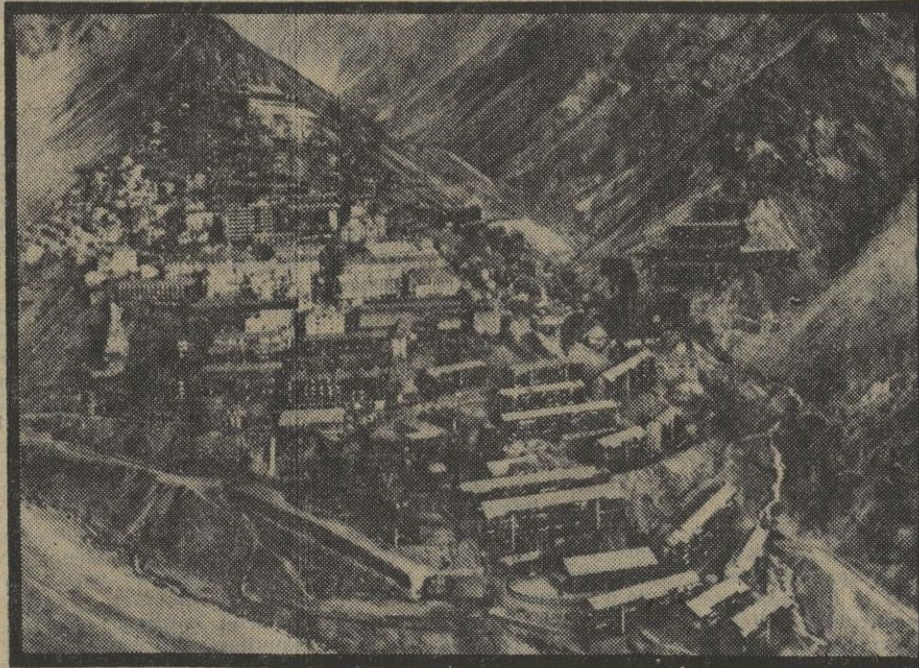
Visita general de la mina «El Teniente». (Foto Cifra.)
