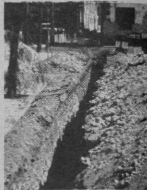
Sigue la zanja abierta Xisco Barceló
