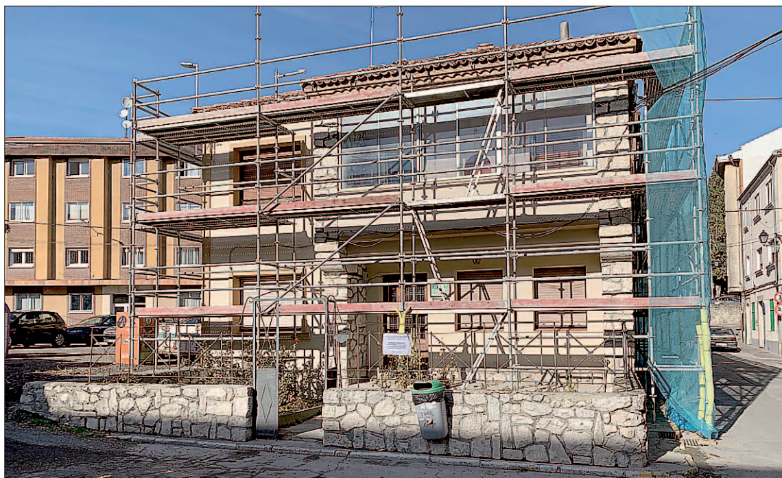
Antigua Casa del Secretario, en obras. / C. NÚÑEZ
