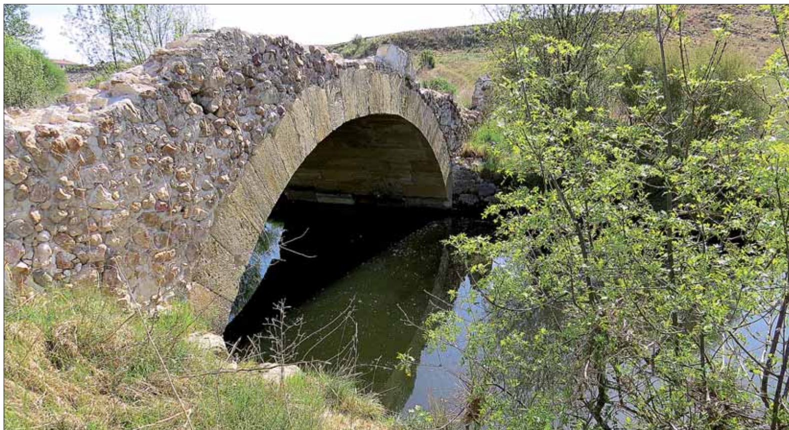
Puente de Torredondo.
