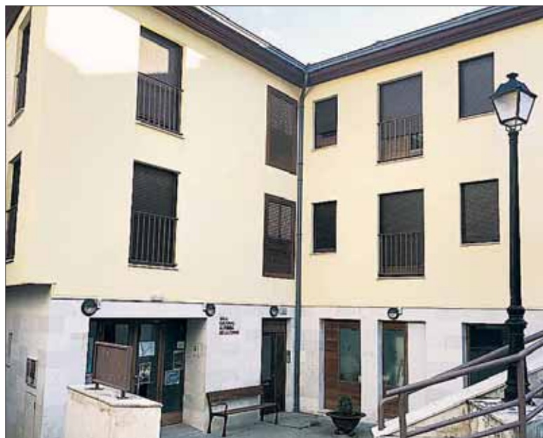
Edificio de viviendas 'Niñas Huérfanas'. / C. NÚÑEZ
