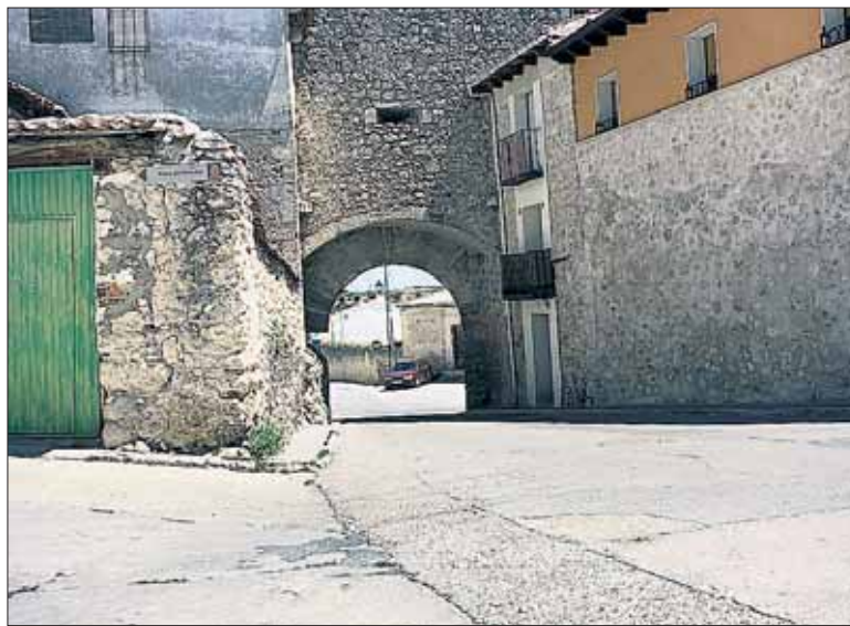
Estado actual de la calle Palacio. / C. NÚÑEZ
