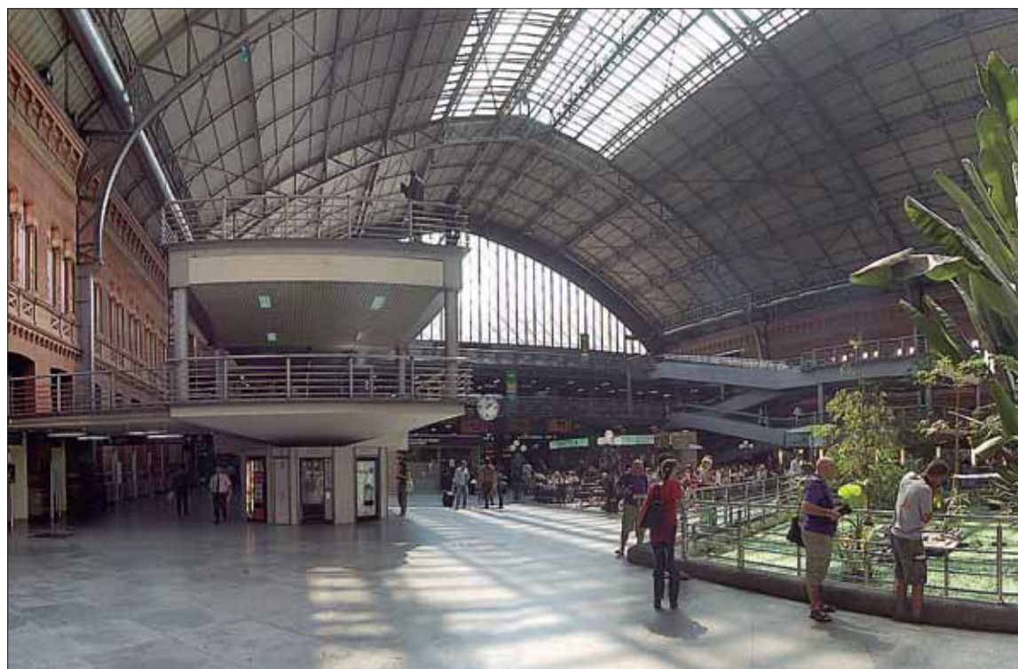
La estación de Atocha se unirá con Chamartín para las obras del túnel del AVE. / EL ADELANTADO
