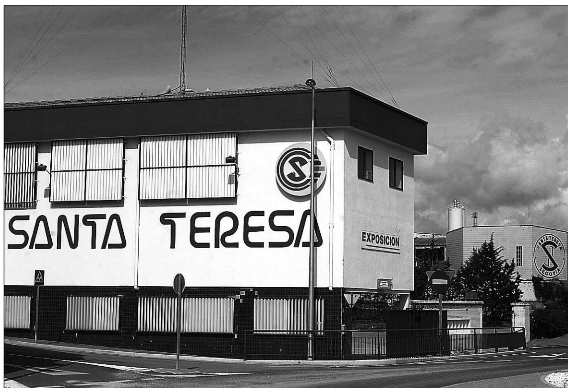
Instalaciones de Santa Teresa Materiales de Construcción S. L., en el municipio de La Lastrilla. / JUAN MARTÍN
