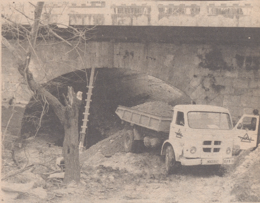
Corte de agua en el Canal. Cauce seco y oportunidad para los que trabajan en la ampliación del puente de la carretera de Valencia. El crecimiento del tráfico ha hecho precisa la ampliación de la misma. Para ello se han derribado edificios y se ha ensanchado el puente sobre el Canal Imperial. Los camiones pueden acercarse ahora hasta los pilares sin miedo a mojarse. Pero eso sí, de prisa. El corte dura pocos días y hay que dejarlo todo terminado.
