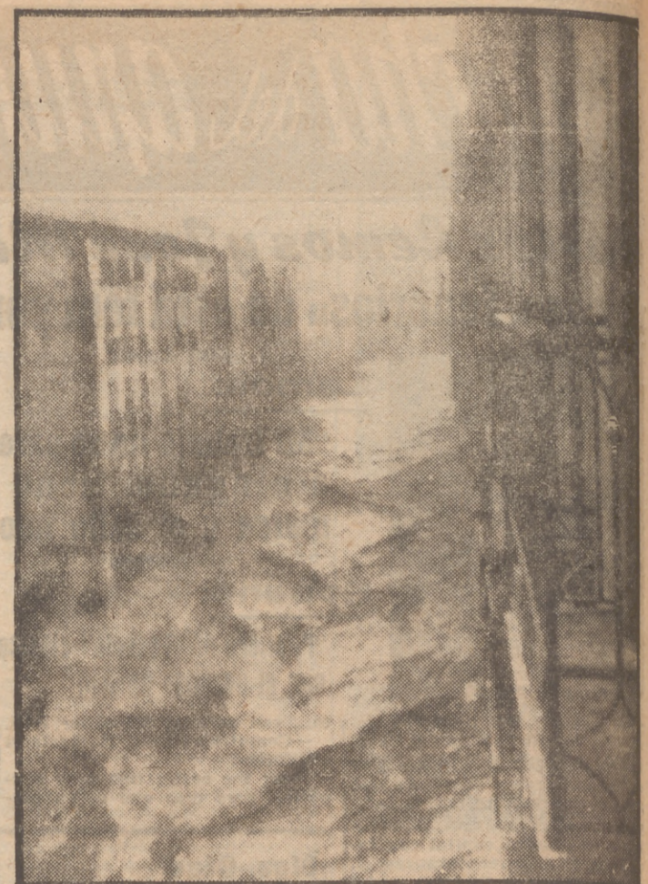
Este panorama trágico corresponde a la carretera San Sebastián-Madrid a su paso por Tolosa. El agua alcanza una altura considerable, y con una fuerza arrolladora, arrastra cuanto se opone a su paso
