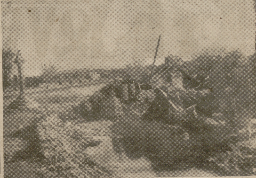
Una vista del pueblo de Moraleja del Peral (Cáceres), en la que se aprecian los desperfectos causados por el desbordamiento del río Rivera de Gata, como consecuencia de la tromba de agua caída sobre la comarca el pasado día 3, de cuyo acontecimiento hemos informado a nuestros lectores. (Foto Karplnt.)
