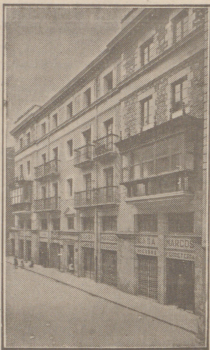
Fachada, por la calle de la Moneda números 16 y 17, de la CASA SOCIAL propiedad de la Federación Burgalesa de Sindicatos Agrícolas Católicos.
