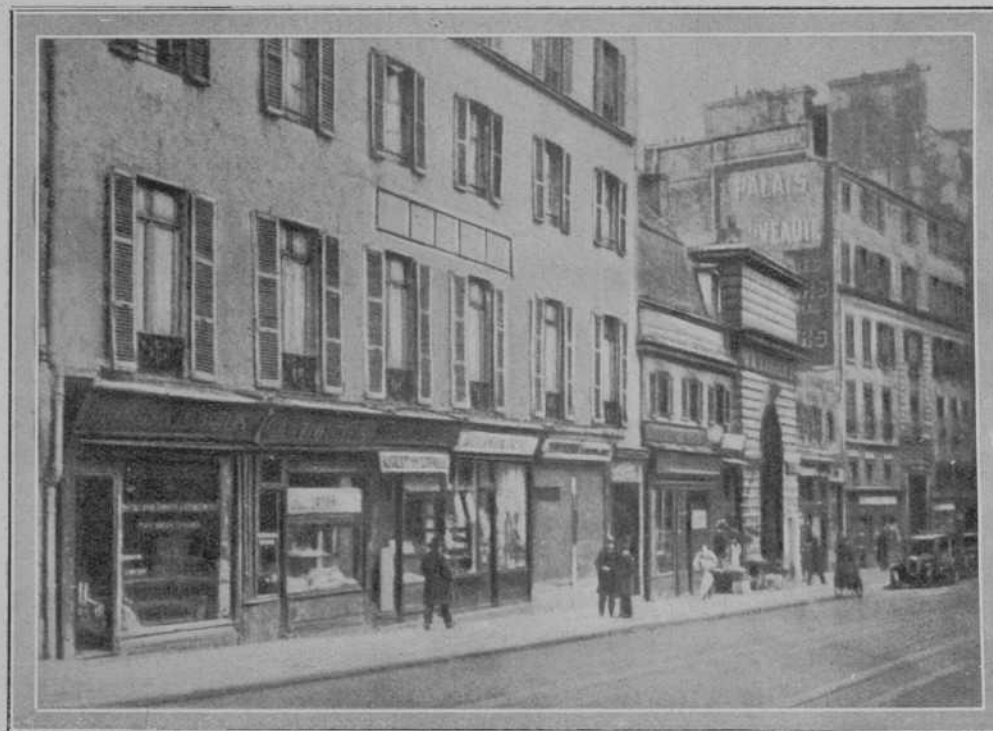
Aspecto actual de las casas del Faubourg Saint Honoré, que han de ser destruidas
