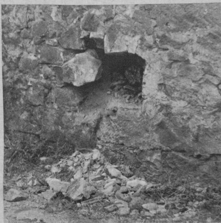
Alcantarilla de desagüe en la que fué colocada la bomba
