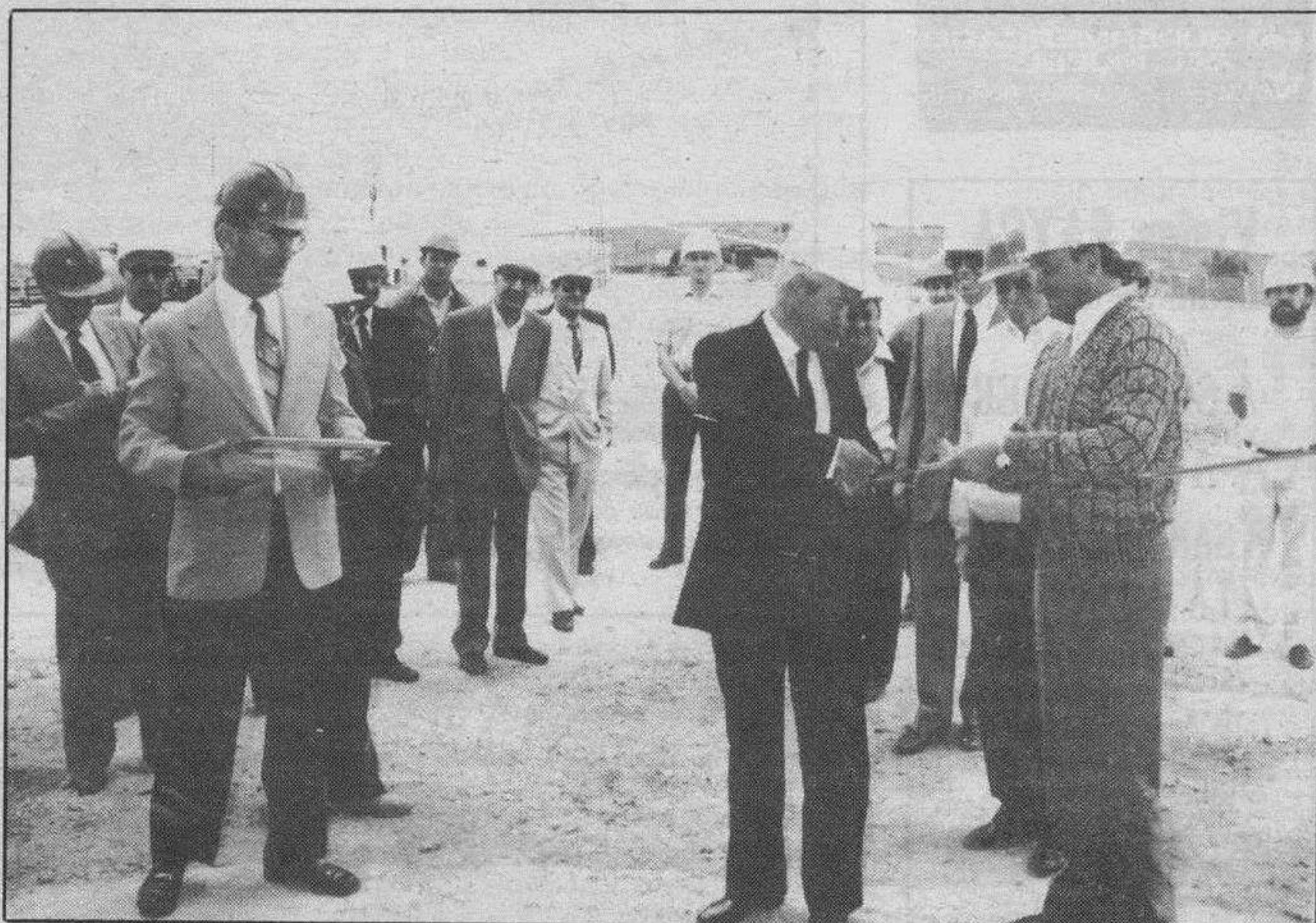
Acto de entrada en servicio del equipo generador de electricidad.
