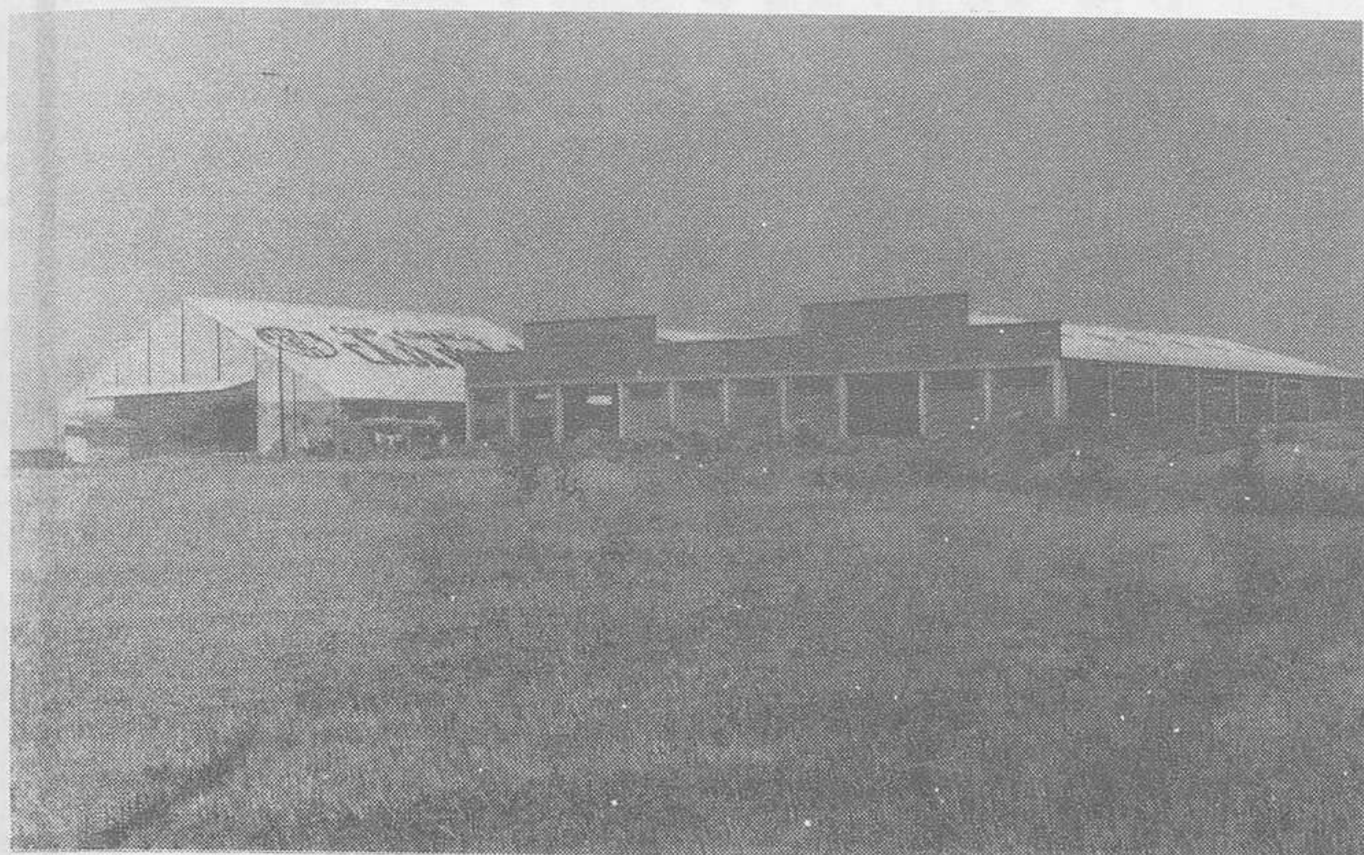
En Villadiego apuntan signos de progreso.
