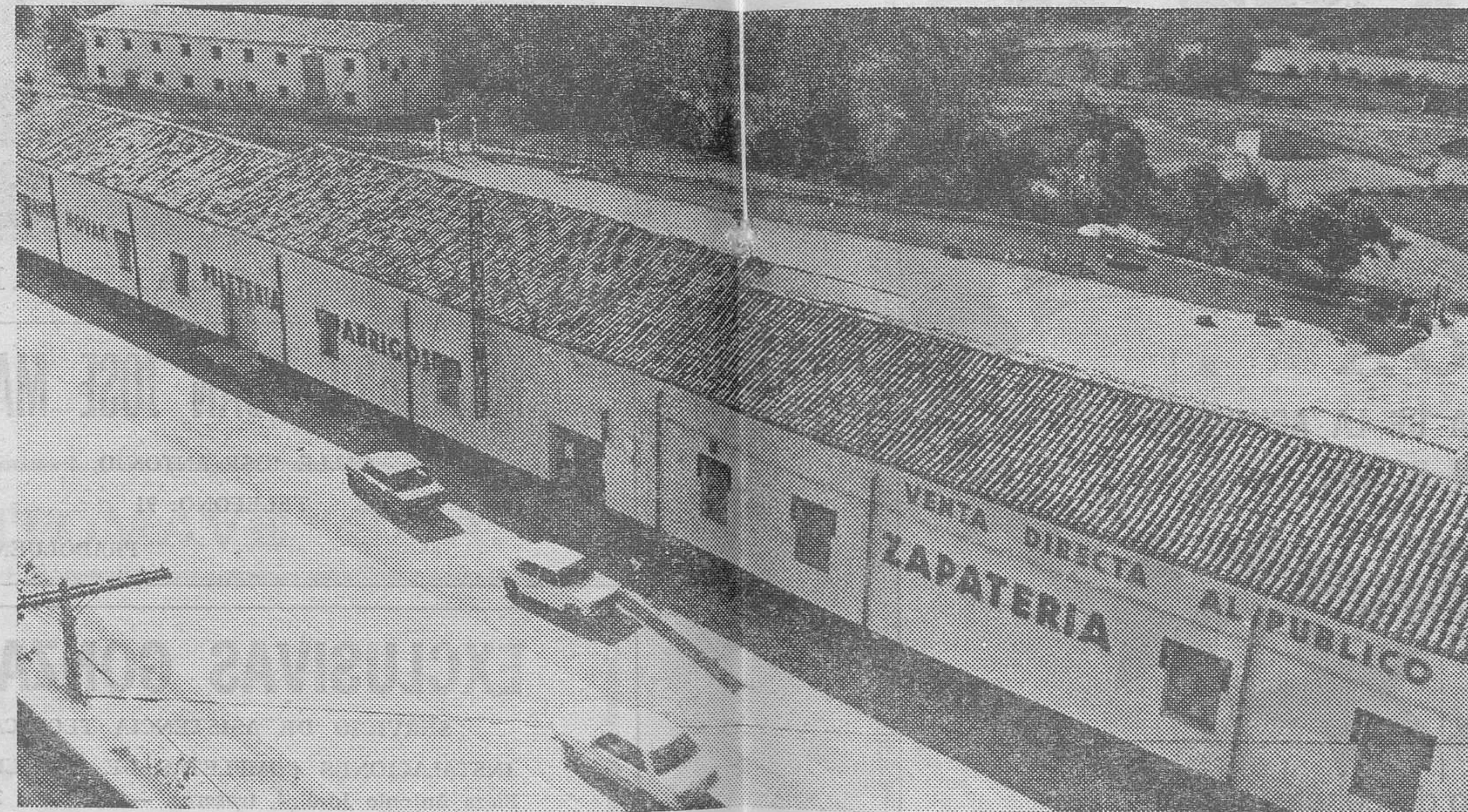
VISTA EXTERIOR DE LA FABRICA
