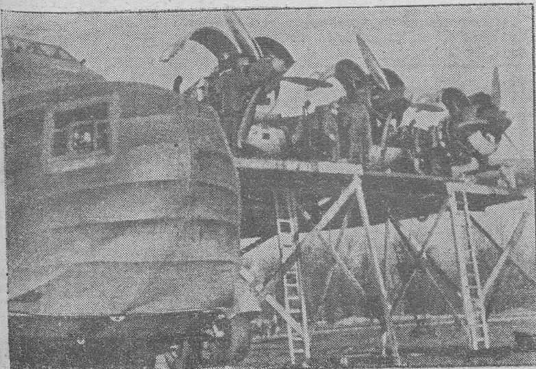
Los motores del coloso “Gigant” han de ser repasados. Para ello los mecánicos alemanes precisan escaleras de seis metros y una instalación especial como muestra la foto
