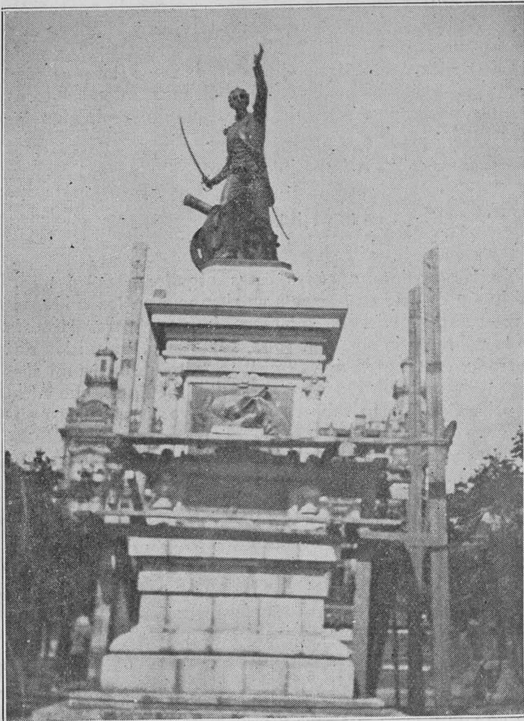
SANTANDER.—La estatua de Velarde, días antes de terminarse los trabajos para su colocación en la Plaza de la Libertad.
