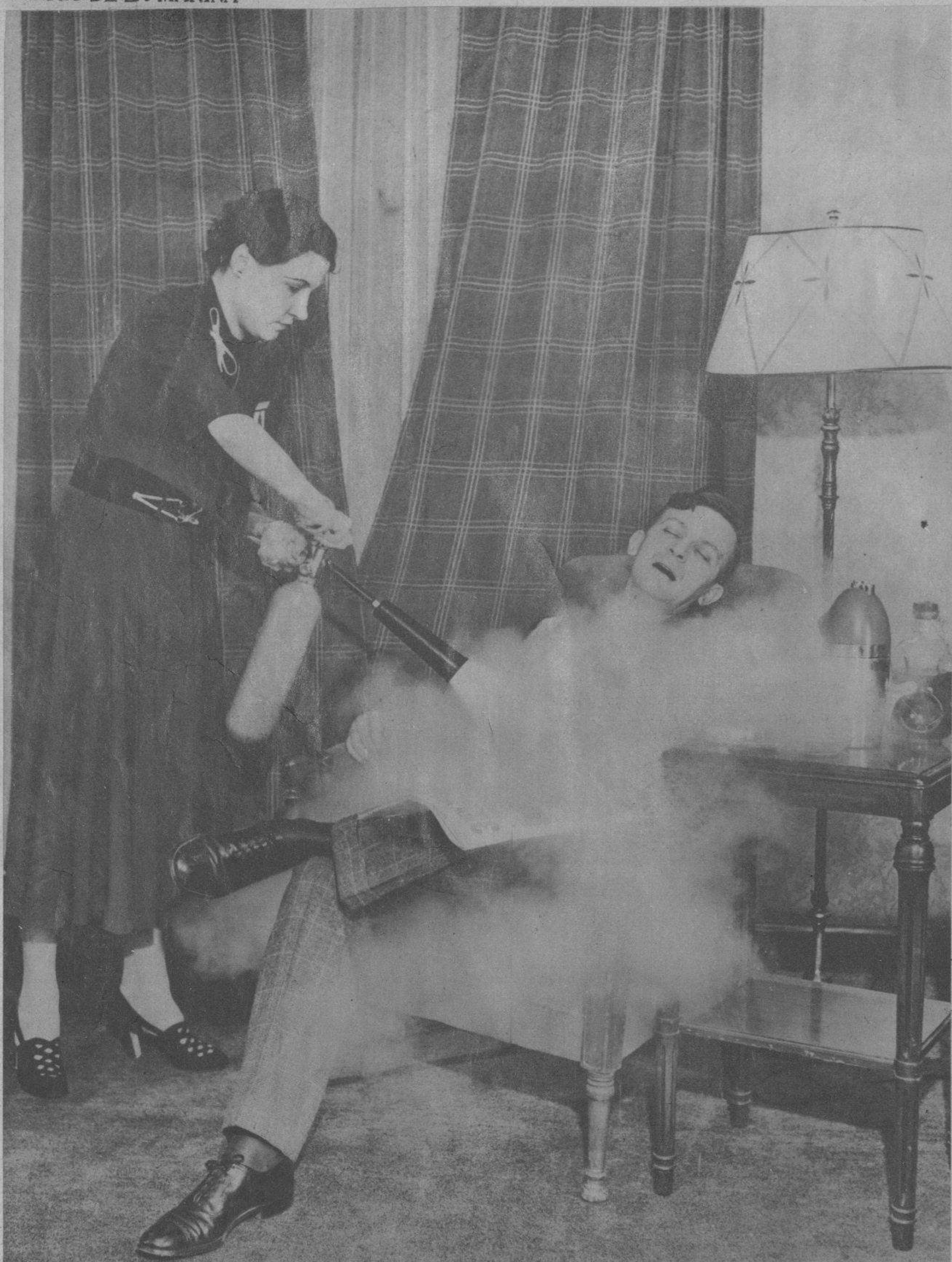
A DESPECHO de su apariencia, esto no es un lanzador de gases asfixiantes, sino un muy efectivo extinguidor de incendios para uso del hogar. Los expertos aseguran que es efectivo y contundente. Produce un humo de gas fórmico que es el resultado de una mezcla de carbón-dióxido y nieve. Además, tiene la garantía de que no destruye la tapicería ni los muebles. Fué exhibido en el Congreso Nacional celebrado en Chicago. (Foto Wide)
