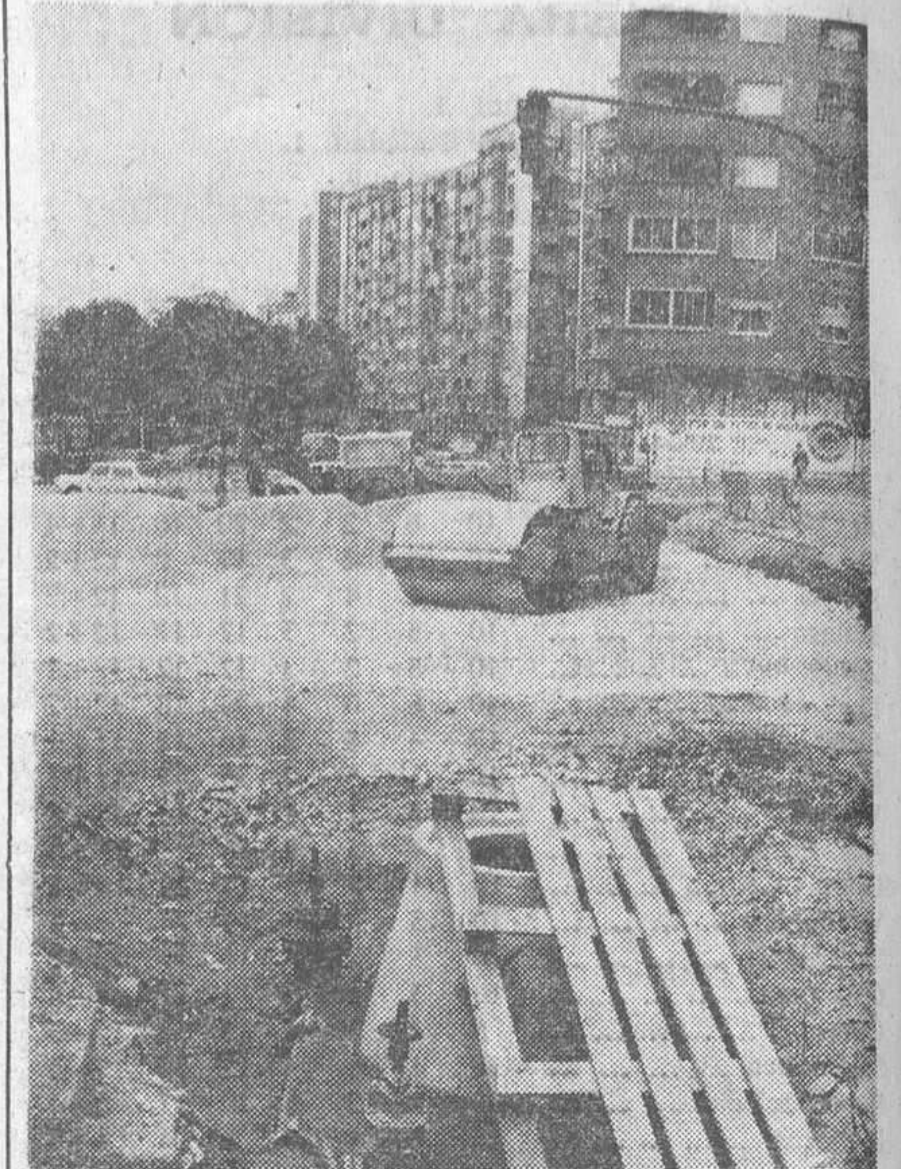
Las obras de la Autovía de Ronda II avanzan ahora, acaso, a mayor ritmo del que ha habido hasta este momento. En Diciembre se cumplirá el año de su iniciación. Se está configurando una nueva ordenación del tráfico de las calles de la Legión, Pisones, Madrid y San Agustín que era muy necesaria. Esta obra la realiza el Ministerio de Obras Públicas y Urbanismo con la colaboración económica del Ayuntamiento de la ciudad.
