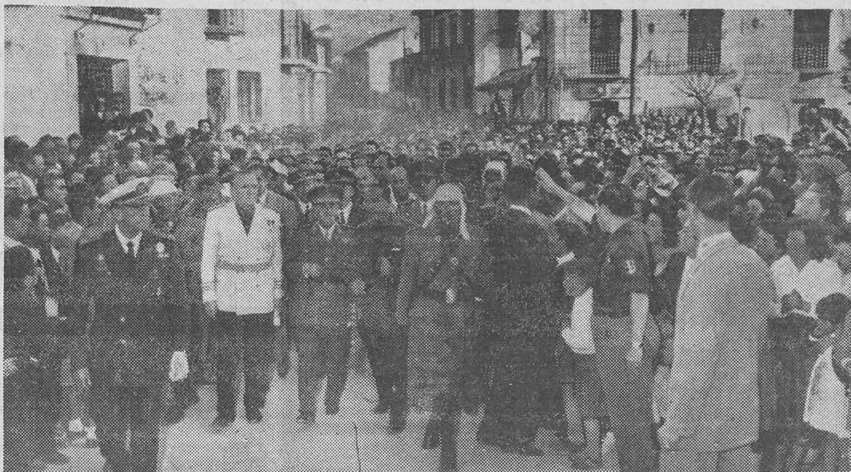
El Caudillo visitó Granada el 2 de mayo. La «foto» recoge el momento en que S. E., en medio del júbilo indescriptible de la población, recorre las calles de Albolote para apreciar la magnitud de los destrozos causados por el terremoto. Entonces el Jefe del Estado ofreció su ayuda, convertida ya hoy en espléndida realidad.—(Foto Torres Molina).
