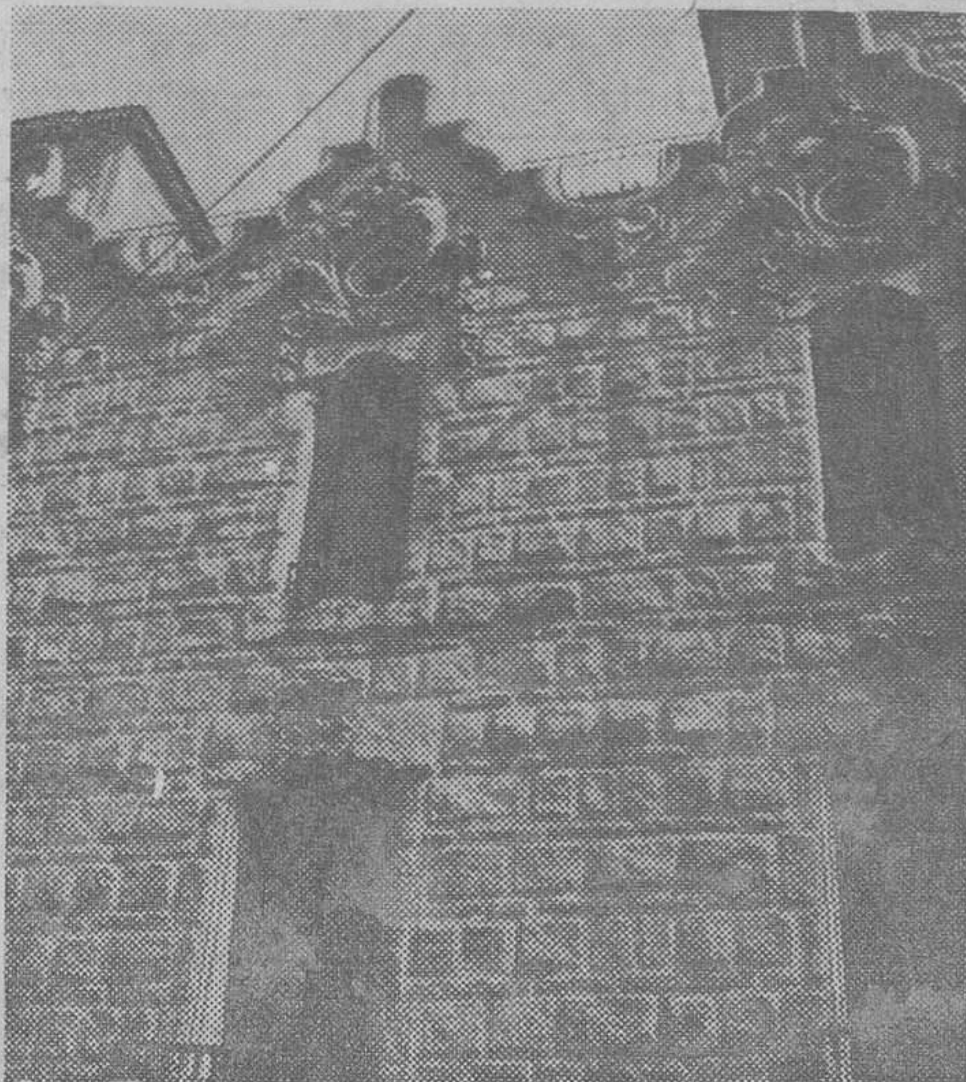
Casa Ravella, radicada en la calle del mismo nombre de la barriada de Sant Gervasi. (Foto: Soterias.)
