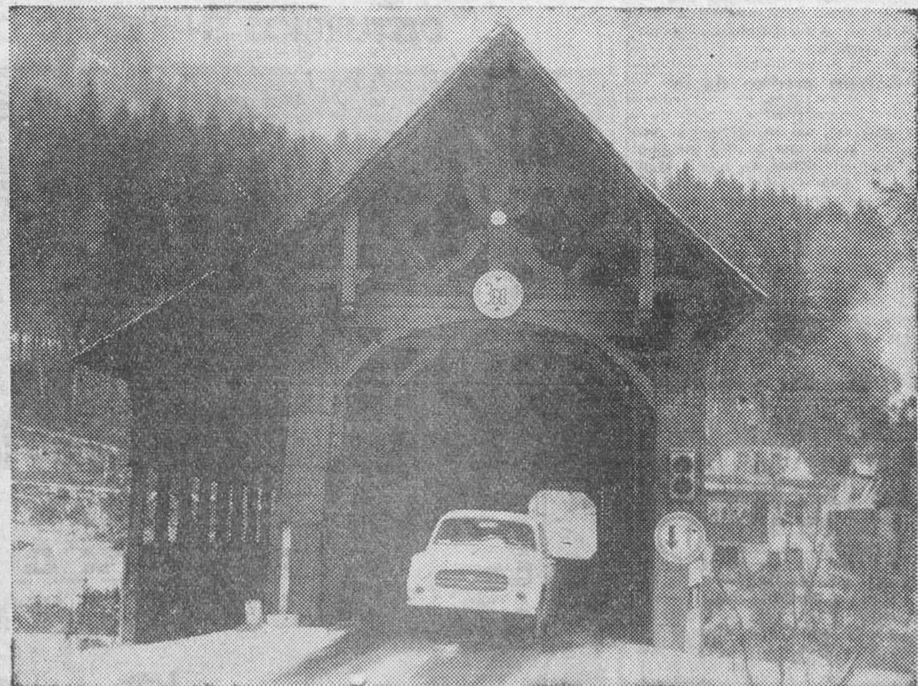
Hace más de 300 años, los frailes de un convento de Beuron, cerca de Sigmarisgen (Alemania) construyeron este puente techado, sobre el Danubio. La madera empleada en dicha obra se ha conservado de tal modo, que hasta la fecha no ha sido preciso ninguna reparación
