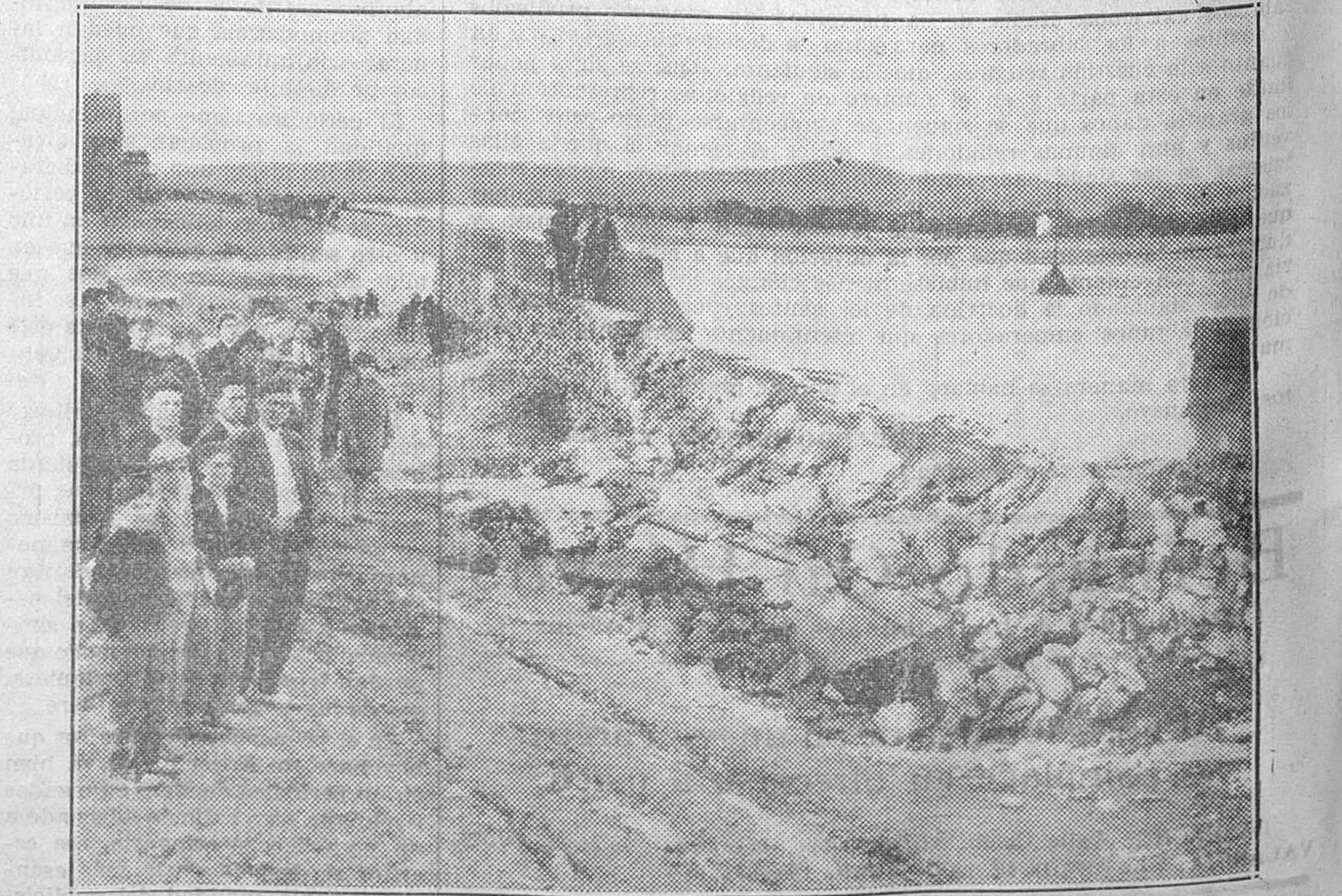
Tercer trozo del malecón que se hundió, frente a la calle de Costa, y cuyo estado demuestra la consistencia de las obras
