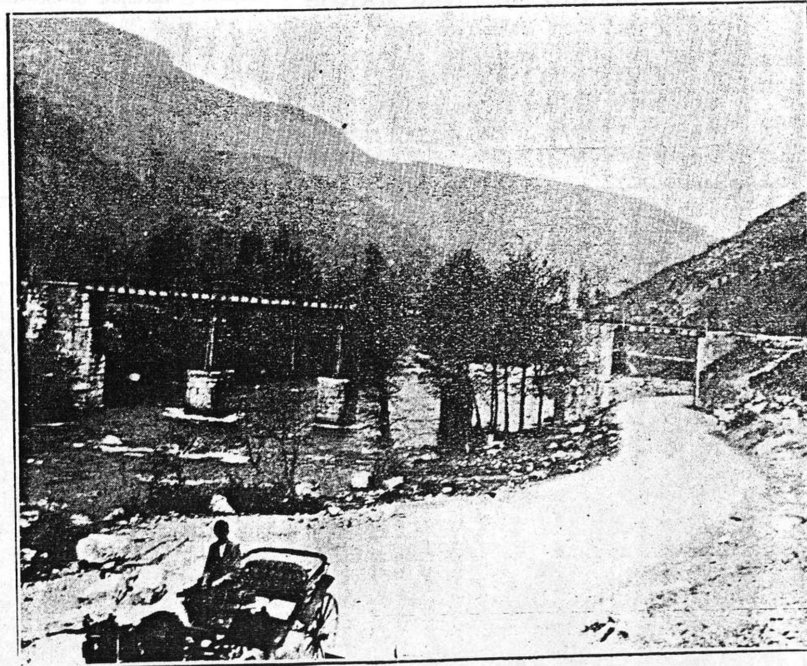
Trubia: el soberbio viaducto de Arenas
