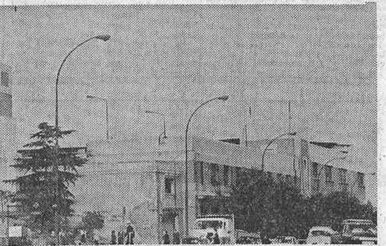
También será demolido el mercado de pescados, para convertirse en un jardín, como prolongación del Campillo del Mundo Nuevo. (Foto Torremocha.)
