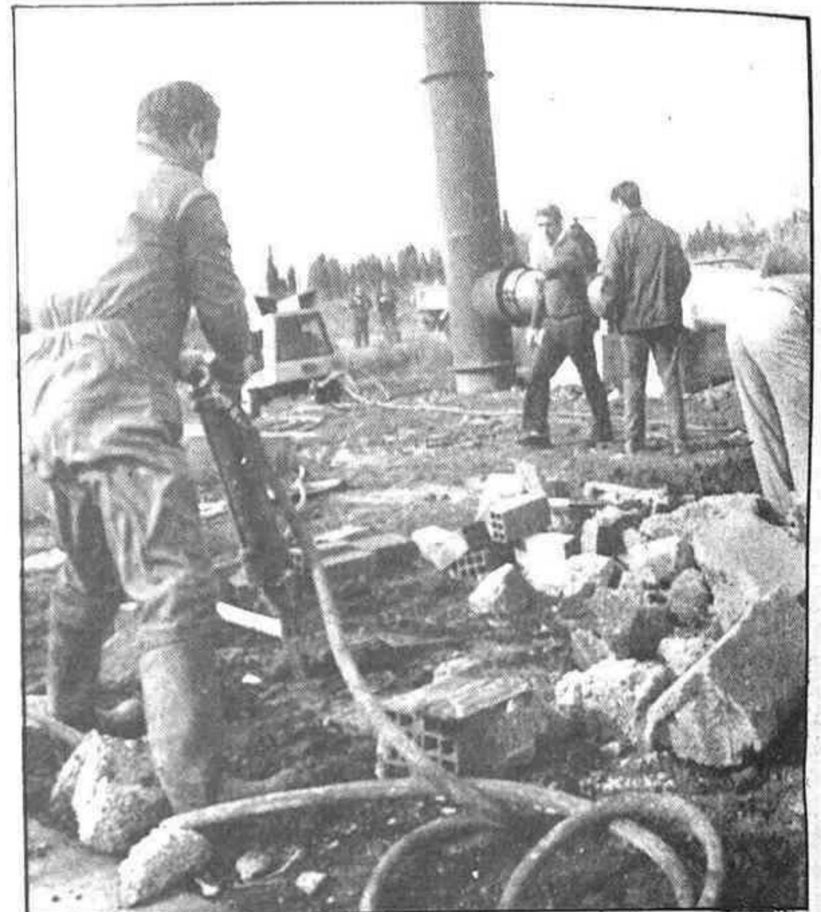
El Ayuntamiento no encontró ningún tipo de resistencia a la demolición de las obras en La Pedrera. / P. GUERRERO.
