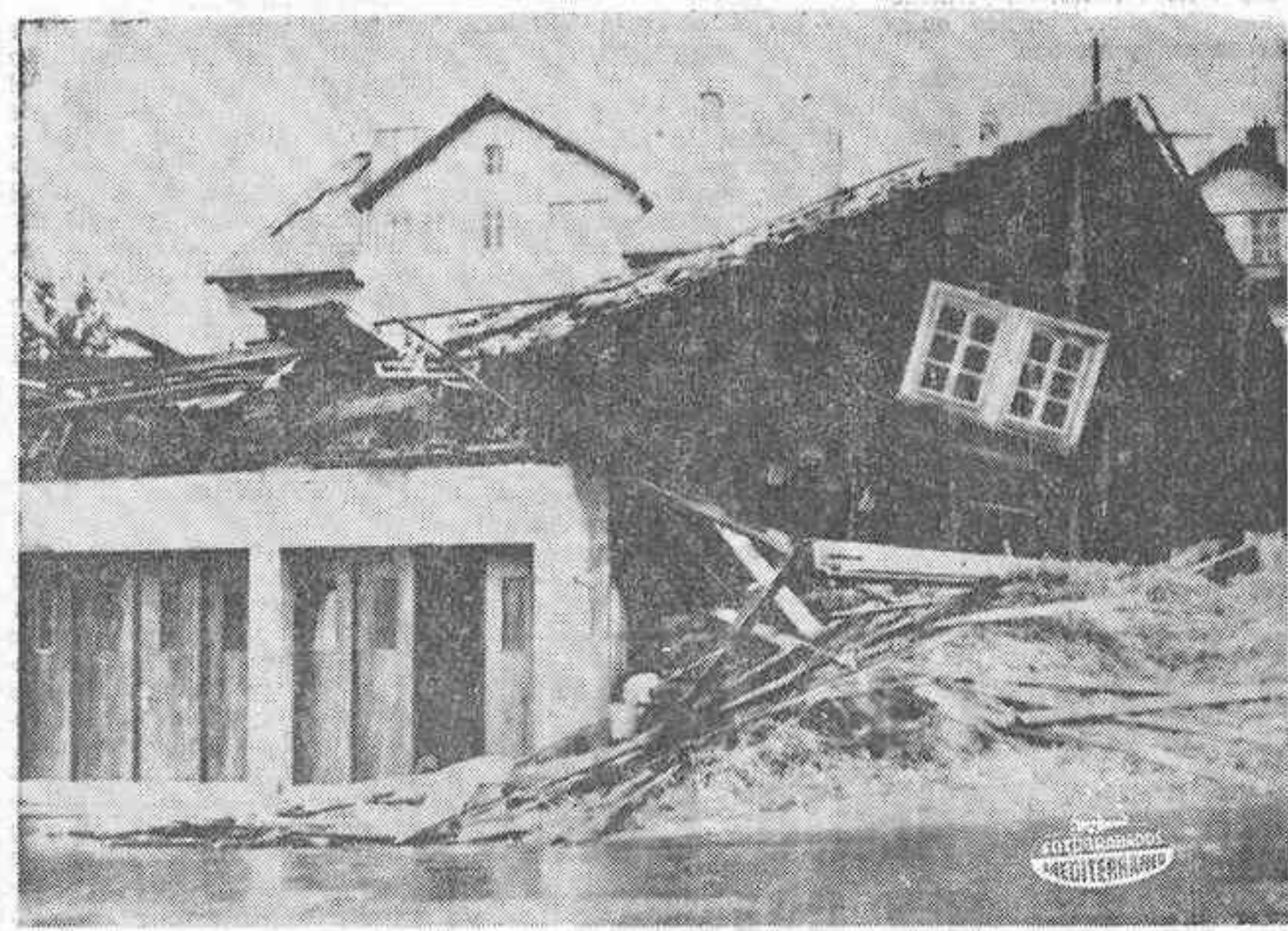
LE BRASSUS (Suiza). — Cinco minutos duró un huracán que ha arrasado el valle de Joux, causando serios daños personales, y arrastrando consigo edificios, bosques, vehículos, e incluso las instalaciones eléctricas. — (Telefoto CIFRA GRAFICA)
