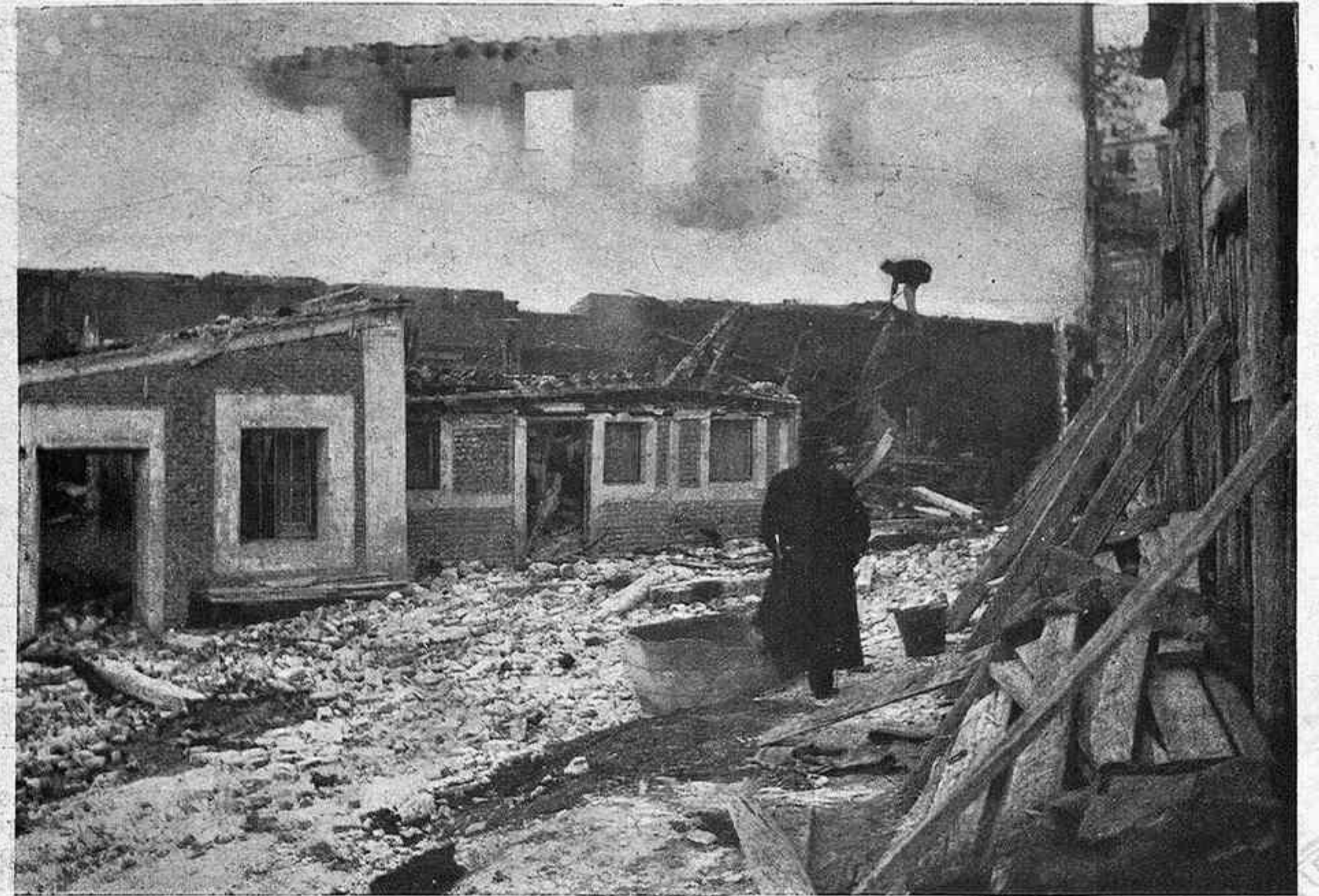
Parte lateral de la fábrica, demolición de paredes.
