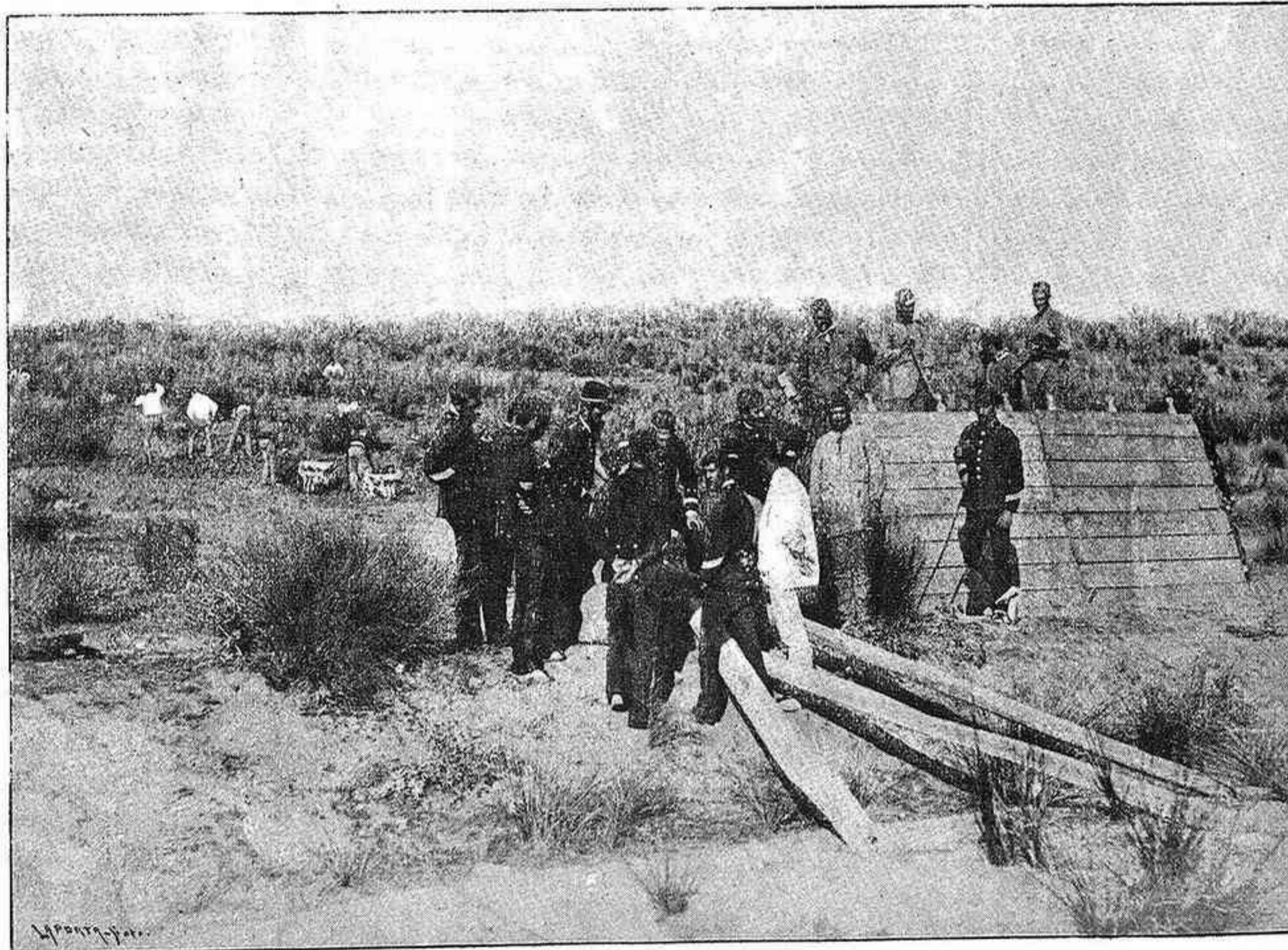
CAMPAMENTO DE LOS CARABANCHELES.—CONSTRUCCIÓN DE FAGINAS (De fotografía directa del Sr. Compañy.)
