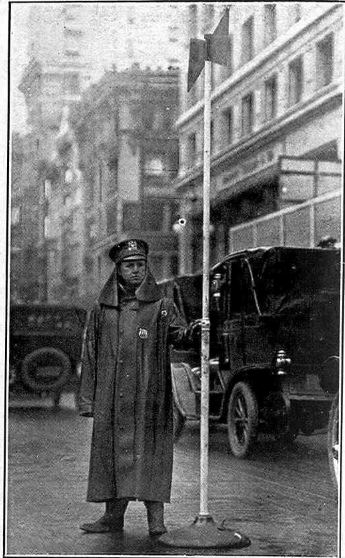
El semáforo instalado en las calles de Nueva York para regularizar la circulación de carruajes FOT. HUGELMANN
