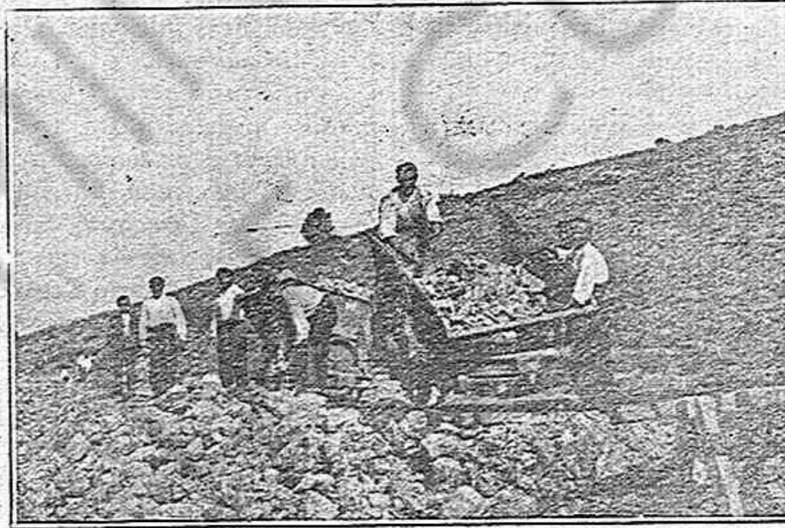
Grupo de obreros trabajando en las obras que se realizan en las inmediaciones de la capital.
