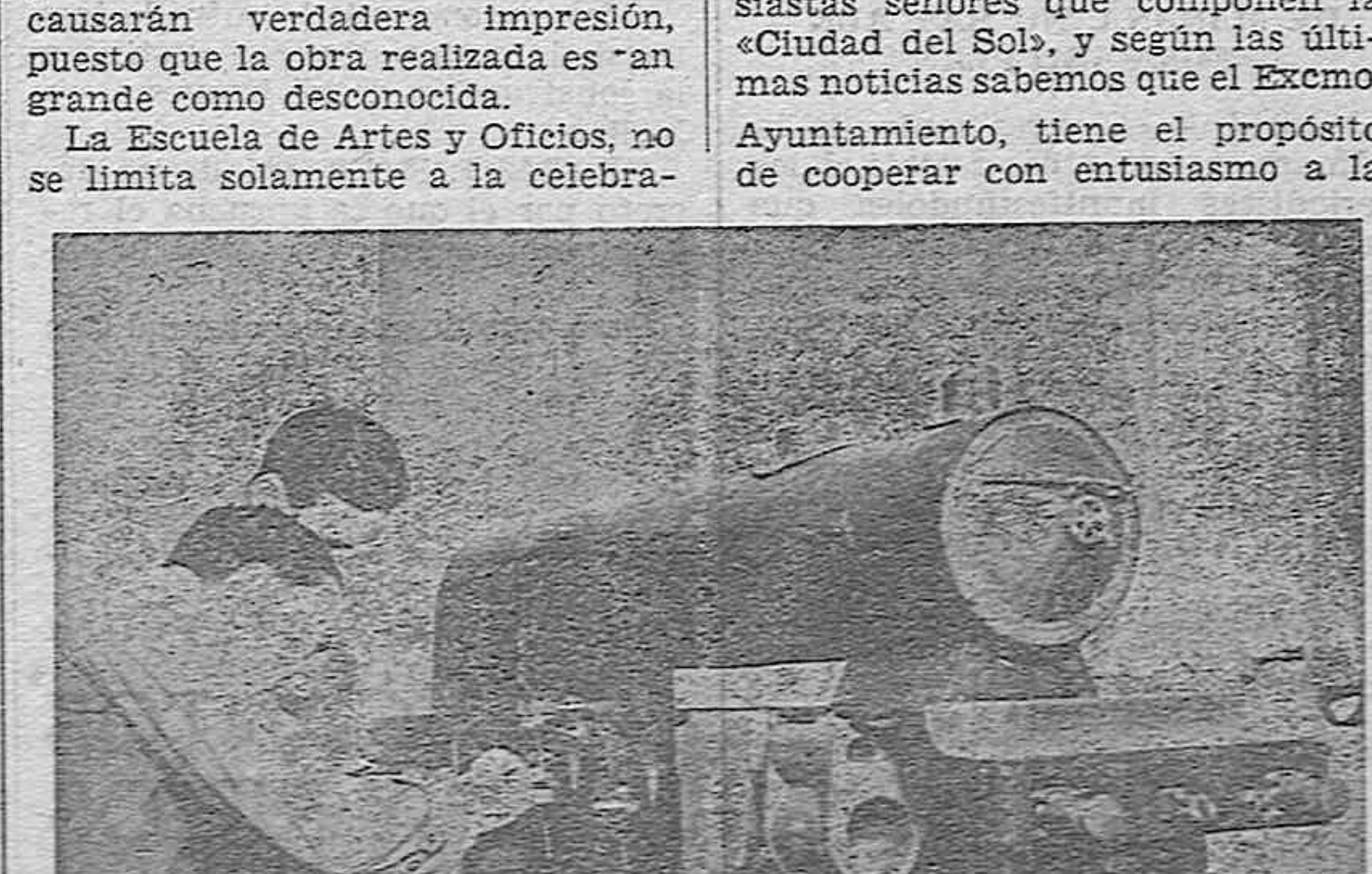
TALLER DE METALES. Construcción de una locomotora último modelo.
